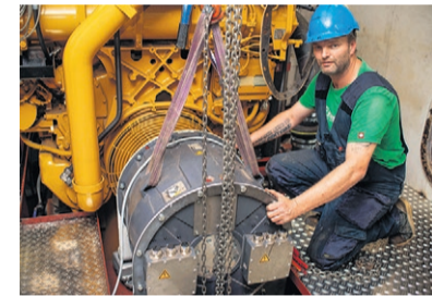
Met een asgenerator op de hoofdmotor, zoals hier op de Monika Deymann, hoeft er geen aparte generator te draaien, met minder uitstoot als gevolg. (Foto Bart Oosterveld)
