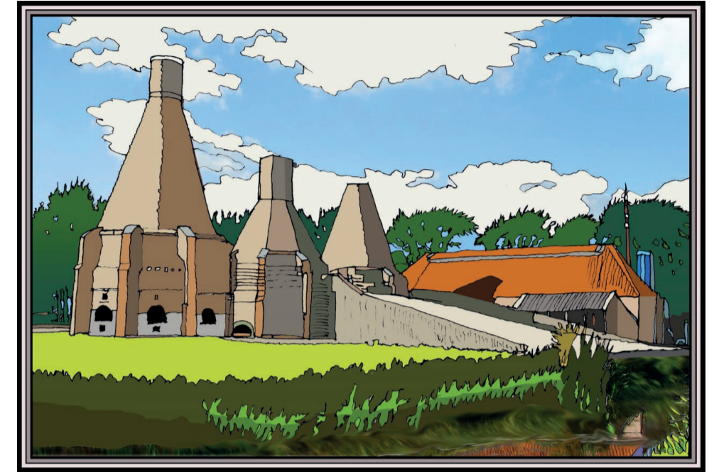
Bij Dedemsvaart werd veel turf gewonnen die via de vaart naar West-Nederland werd vervoerd. De retourolading bestond uit schelpen die in deze ovens in Dedemsvaart tot kalk werden gebrand.
